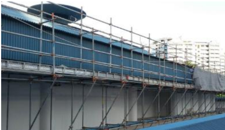
圖 32 懸挑式腳手架
