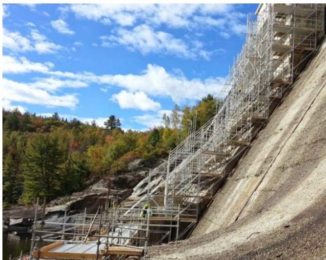
图34 系统脚手架
